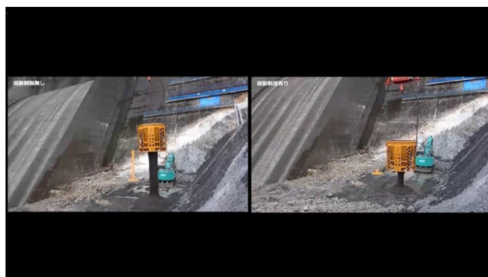
放出時における揺動抑制の比較（左：揺動抑制無し、右：揺動抑制有り）
