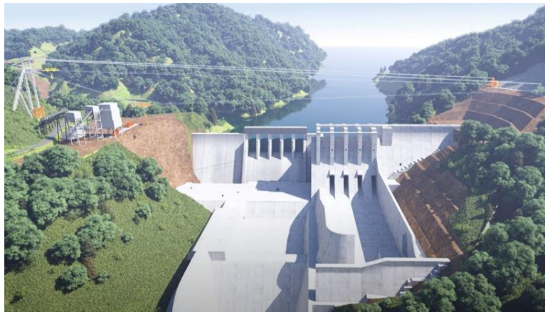
新丸山ダムにおけるケーブルクレーンの自動・自律運転の様子 （動画再生時間：3分46秒）
