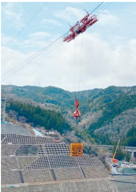
ケーブルクレーンによるコンクリート運搬
