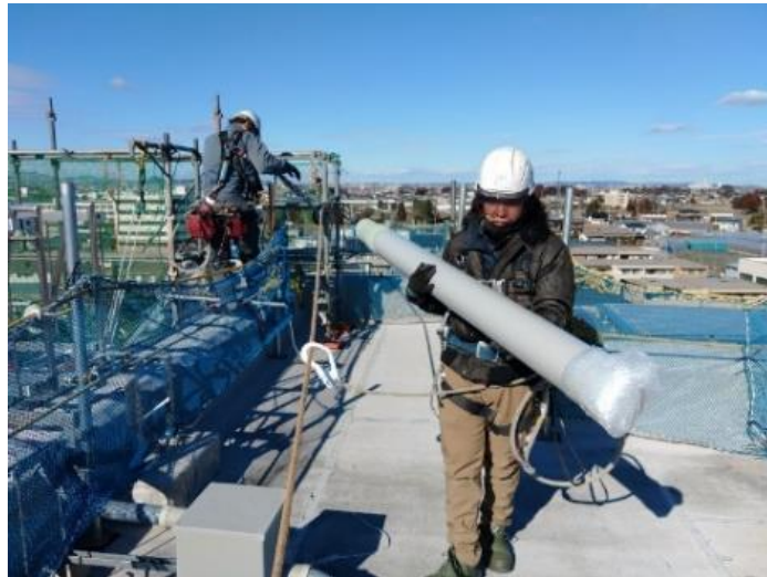
<本支持柱を搬入する様子>
